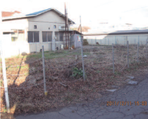
トイレ&緑地建設予定地 (8月にはすっかり様変わりの予定)
